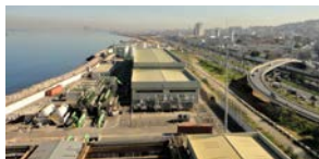
Hamma, Algeria – BOT Desalination - 200 mld
